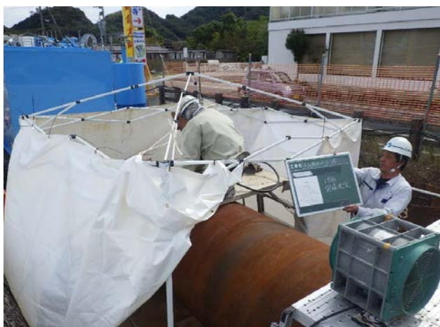
鋼管杭に杭先にピットを溶接する作業、火花・煙が発生するので囲いを設置し環境に配慮した。
