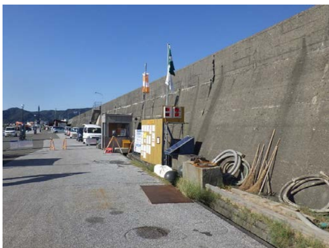
鋼管杭を圧入するため騒音・振動を常に観測し、周辺環境に配慮をする。
