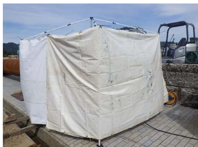
鋼管杭に杭先にピットを溶接する作業、火花・煙が発生するので囲いを設置し環境に配慮した。
