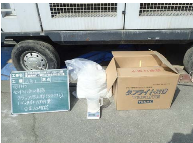
モルタル吹付時 セメントにクラック防止剤、タフライトRG配合 (クラック制御ポリプロピレン短繊維NETIS登録 KK-100117-V(地球に優しい、緑の環境づくり。TESAC))
