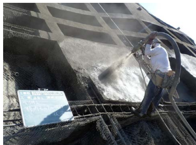
モルタル吹付時 セメントにクラック防止剤、タフライトRG配合 (クラック制御ポリプロピレン短繊維NETIS登録 KK-100117-V(地球に優しい、緑の環境づくり。TESAC))
