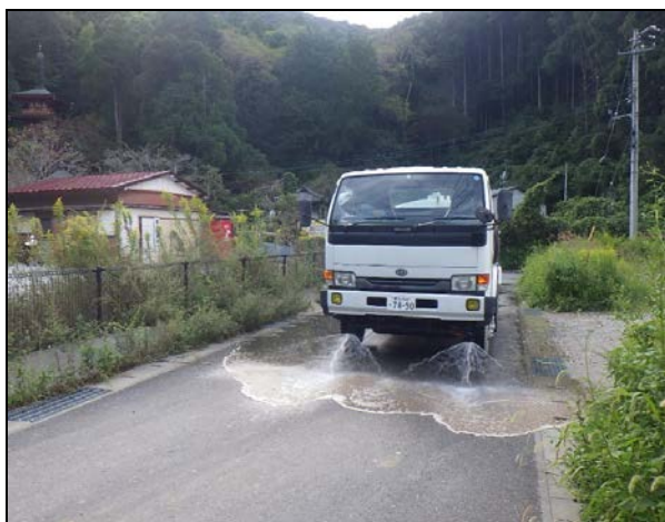
周辺道路を粉塵対策で散水
